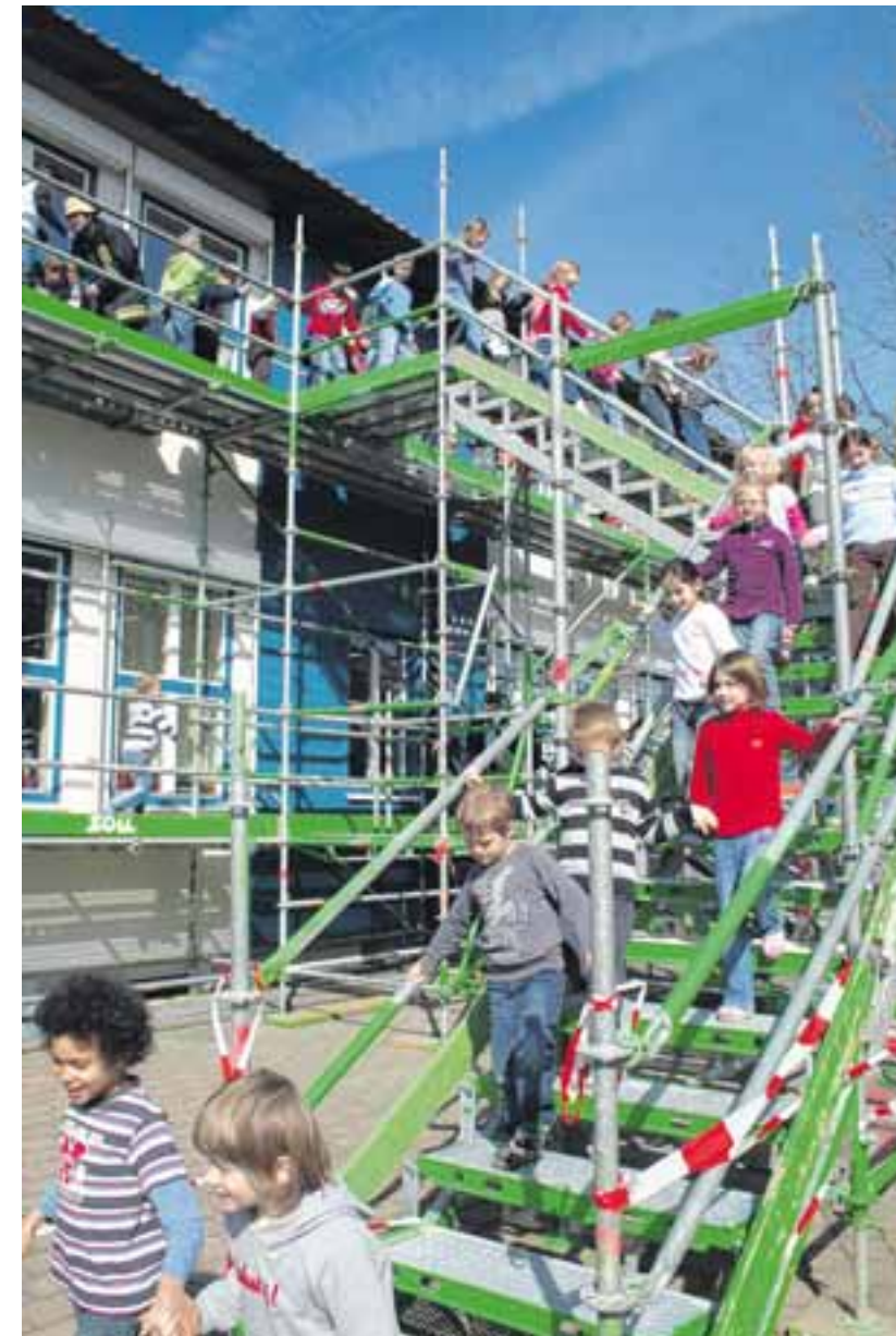
Reibungslos lief gestern die Alarmübung an der Füssener Grundschule ab: Binnen kurzer Zeit hatten die Kinder – hier Erst- und Zweitklässler – ihre Klassenzimmer über das Gerüst verlassen. Foto: Heinz Sturm
