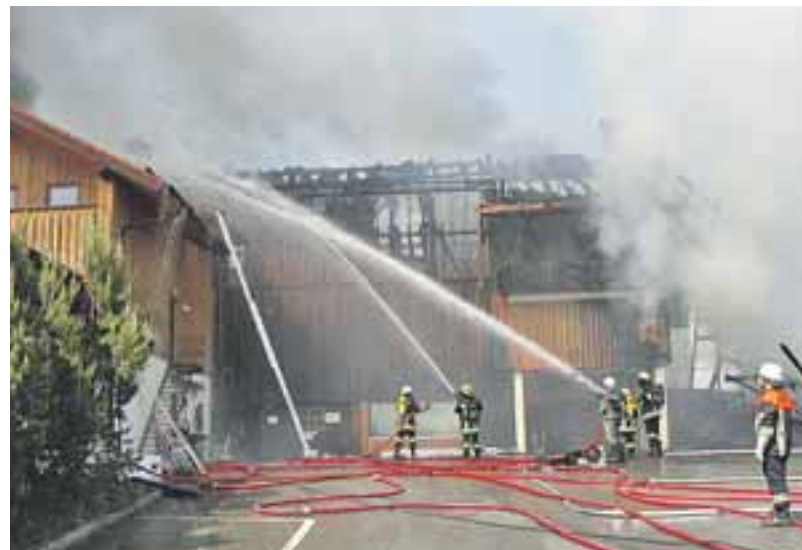
Der Dachstuhl sowie Teile der Ferienwohnungen und Gästezimmer wurden bei dem gestrigen Brand zerstört. Die Wirtschaft indes konnte die Feuerwehr retten.
